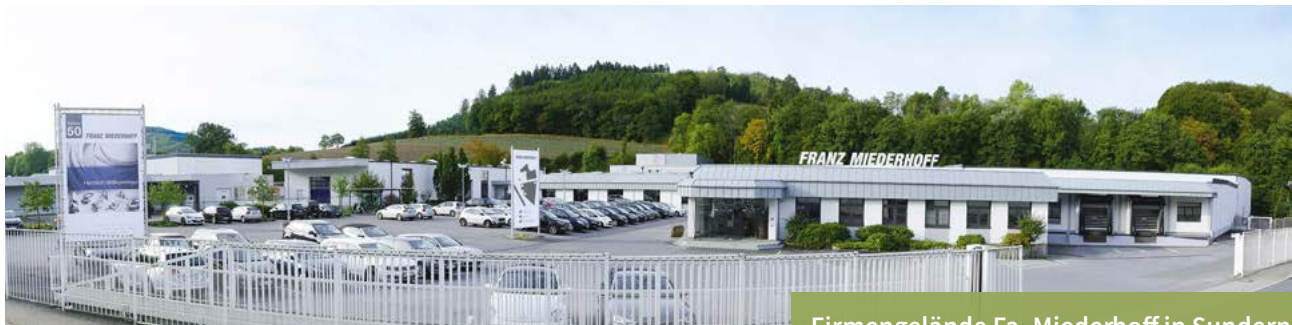
Firmengelände Fa. Miederhoff in Sundern
